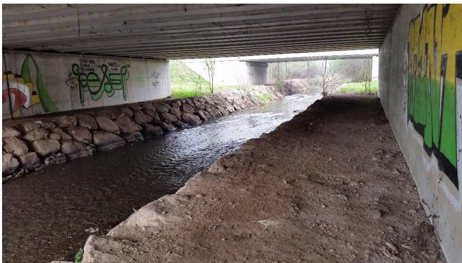
Figura 4: esempio di passaggio faunistico realizzato dalla società Autostrade centro Padane sul Vaso Fiume
